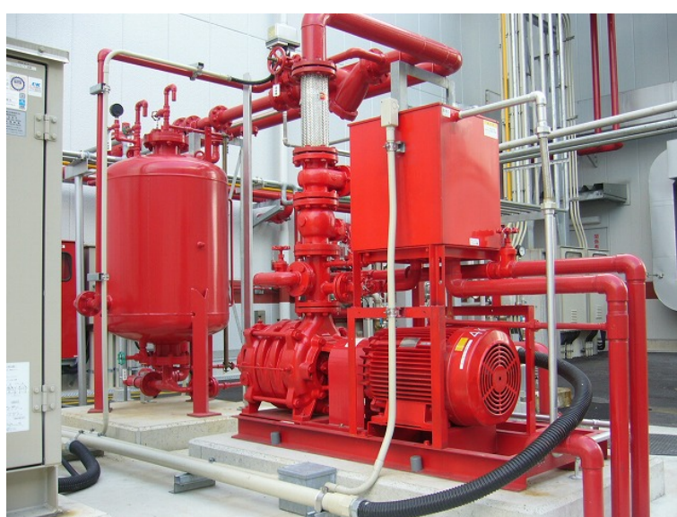
圖 2-27 加壓送水裝置（幫浦）與泡沫原液槽（資料來源：同註 1）
