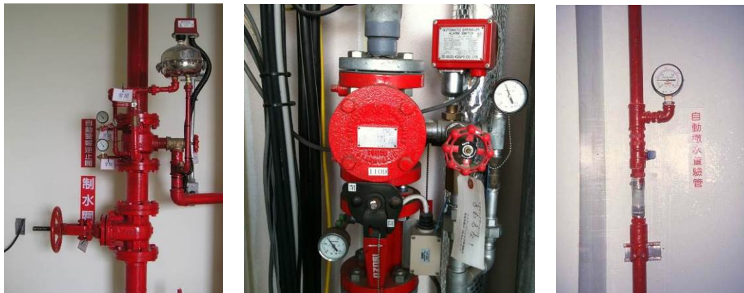
圖 2-25 流水檢知裝置與末端查驗閥（資料來源：同註 1）
