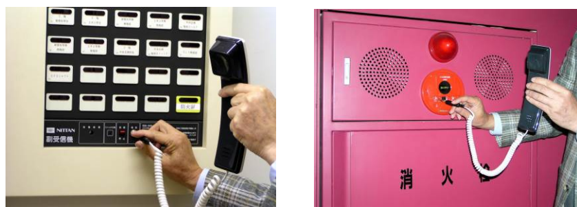
圖 2-31 總機與火警發信機電話插孔
